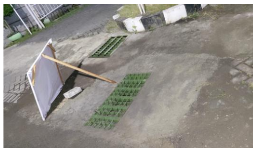
Gambar 22. Grating Setelah Dicor dan Dicat di Atas Ujung Selokan Lama yang Telah Disambung dengan Gorong-gorong Lubang Silindris ke Gorong-gorong Lubang Segi Empat.
