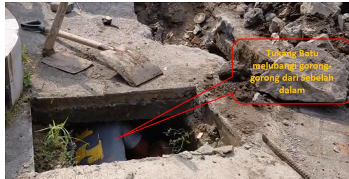
Gambar 11. Posisi Pelubangan Gorong-Gorong Lubang Segi Empat yang Sulit Dilakukan oleh Tukang Batu dengan Pahat Baja dan Palu Baja dari Sebelah Dalam.
