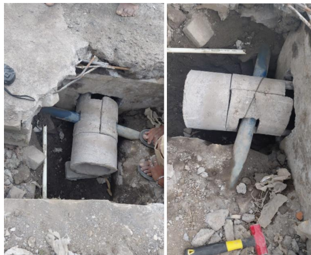
Gambar 18. Posisi Pipa PDAM Warna Biru yang Dimasukkan ke Dalam Gorong-gorong Lubang Silindris 20 cm yang Dibelah dan Disatukan Kembali Sebelum Dicor Beton Semen.
