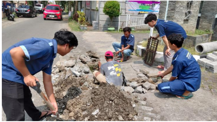
Gambar 9. Penggalian tempat gorong-gorong lubang silindris yang akan dipasang sebagai penghubung antara gorong-gorong lubang segi empat dan ujung selokan lama.
