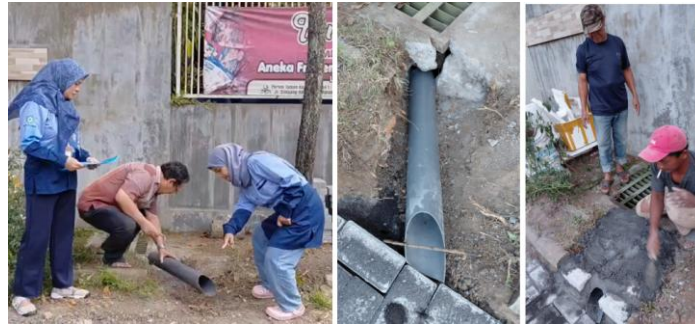
Gambar 17. Pembuat Sudetan Air dari Jalan Beraspal Dialirkan Masuk ke Dalam Gorong-gorong Lubang Segi Empat dengan Pipa Paralon Berdiameter 4 Inci.
