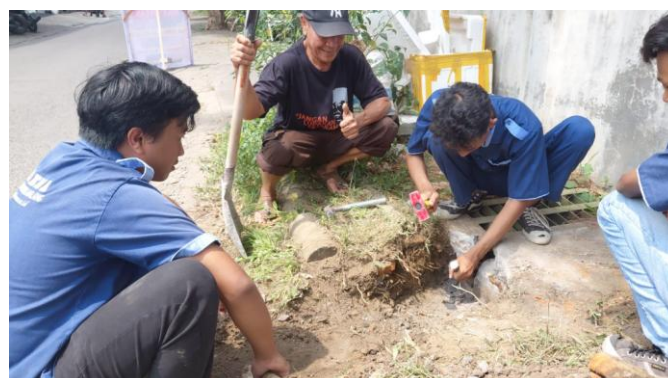
Gambar 13. Mahasiswa melubangi sudetan air pada gorong-gorong lubang segi empat dengan pahat baja dan balu baja dibantu oleh Pak Satpam.
