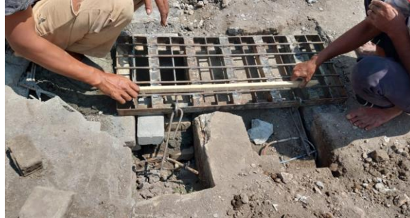
Gambar 20. Persiapan Pengecoran Angker Tempat 2 Buah Engsel Grating/Grill dari Konstruksi Baja dengan Elevasi Dapat Mengarahkan Air Hujan Mengalir Masuk Selokan.
