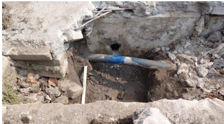
Gambar 10. Kasus ditemui pipa PDAM ternyata telah terpasang di sebelah Utara gorong-gorong lubang segi empat yang menghalangi penempatan gorong-gorong lubang silindris.
