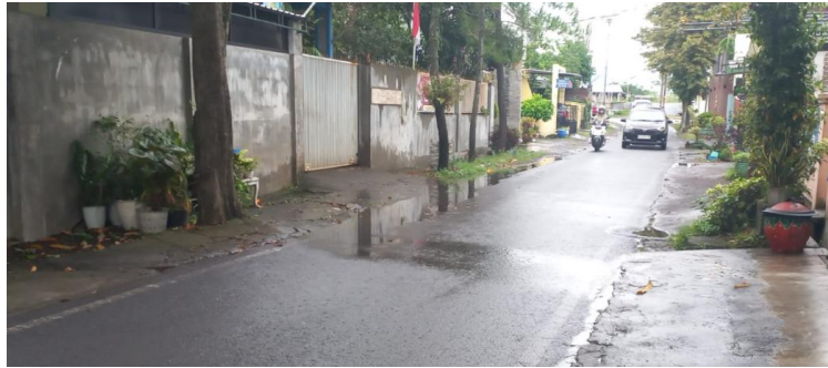
Gambar 3. Keadaan Genangan Air di Jalan Beraspal dan Trotoar Setelah Hujan.
